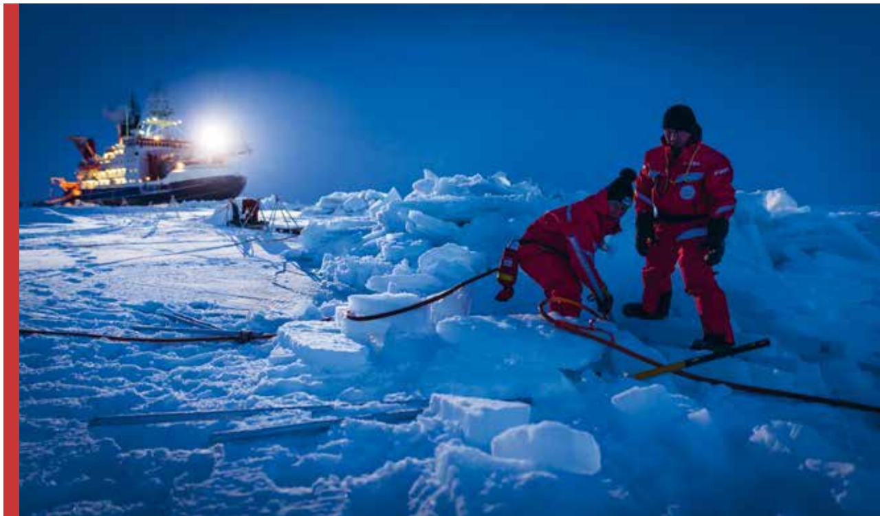
Zwei Forscher bergen ein Stromkabel, welches verschüttet worden war, nachdem sich ein Presseisrücken aufgetürmt hatte.
